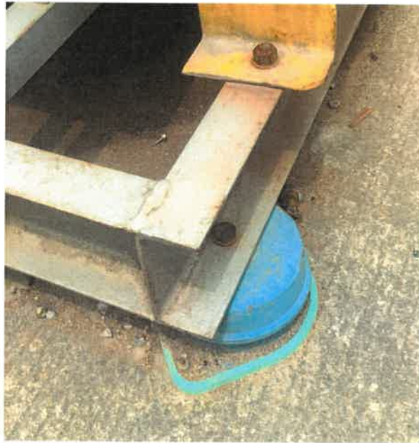
图 4-3 风机设备减振基座
